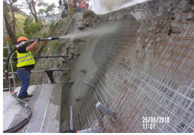
Confortement de talus par voie sèche.
