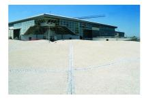
Gris ou blanc, le ciment, mélangé aux éléments les plus fins du sable donne au béton brut sa teinte de fond qui peut être modifiée par l'ajout de colorants. Dans le cas des bétons désactivés, c'est la couleur des granulats qui influencera la teinte du béton.
