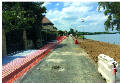
Avant. L'ancien chemin au début des travaux.
