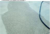
Quarante-huit heures après la mise en œuvre, un atelier d'hydrosablage par voie humide est intervenu pour retirer la peau du béton et faire apparaître les
