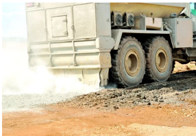
Épandage du liant hydraulique routier Rolac® Premier 635 de LafargeHolcim sur le fraisat de l'ancienne chaussée préalablement défragmentée.
