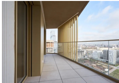
Les balcons prolongent les séjours très généreusement vitrés, de jour comme de nuit, les balcons offrent un rapport immédiat à la ville et au ciel.
