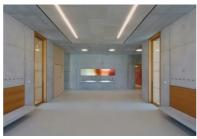
Le béton brut des murs séparatifs, la présence de la lumière naturelle, le bois de mélèze des menuiseries ou des rangements, les larges vues sur l'extérieur caractérisent l'ambiance intérieure. L'ensemble du bâtiment est construit en béton coulé en place. Les façades sont des doubles murs isolés en béton, constitués d'un voile extérieur de 20 cm, d'un isolant de 20 cm et d'un voile intérieur de 20 cm. La toiture-terrasse est isolée par l'extérieur.
