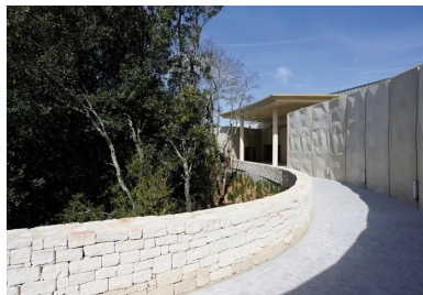
La galerie de l'Aurignacien réinterprète l'idée de triangulation dans des panneaux de béton matricé.
