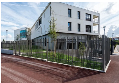
Le système structurel associe planchers, murs de refends intérieurs et façades porteuses coulés en place en béton blanc autoplaçant.
