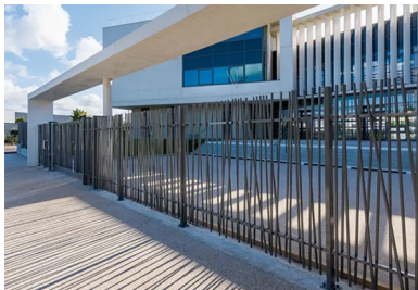
Un grand portique en béton blanc met en scène l'accès de l'établissement.
