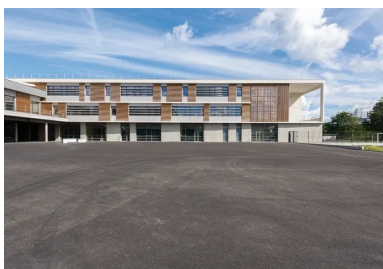
Peintes ou revêtements de bois ligné, les façades courantes s'inscrivent entre des éléments horizontaux en béton blanc.
