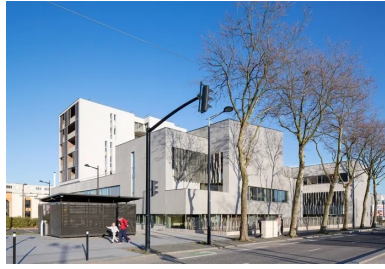
À l'arrière du du siège social, le bâtiment des logements, protégé des nuisances sonores de l'avenue.
