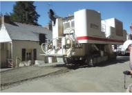
Vue de l'arrière de l'aRC 1000 d'Elfage. Cette véritable « centrale mobille » déconésionne l'ancienne chaussée « transversalement et verticalement », mélange le liant avec le matériau en place avant l'homogénéisation de l'ensemble des constituants à l'aide d'un malaxeur intégré.
