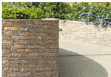
Pour stabiliser les aires, un mur de soutènement a été construit sur les trois quarts du tracé. Des traversées de route, avec grille en fonte, ont été aménagées tous les 10 m.
