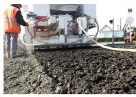
avec le mélange homogène résultant du broyage de l'ancienne chaussée préalablement scarifiée.
