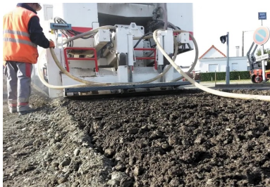
L'ARC® 1000 vu de l'arrière, avec le mélange homogène résultant du broyage de l'ancienne chaussée préalablement scarifiée.
