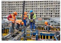
un système de protection qui descend au fur et à mesure de la démolition.
