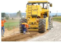
Derrière le malaxeur Bomag RS 650, un technicien vérifie visuellement l'homogénéité mélange entre le matériau d l'ancienne chaussée et le lia hydraulique, et un autre mesure la teneur en eau du matériau traité.
