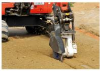
Le département de la Drôme a opté pour la technique préventive de préfissuration. Le groupement E26-Guintoli a mis en œuvre deux systèmes de sciage, dont une dent crantée montée sur une pelle, intervenant systématiquement tous les quatre mètres pour canalise les éventuelles fissures transversales.
