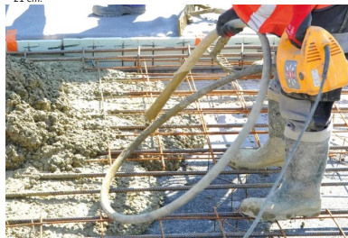
Une aiguille vibrante est utilisée pour chasser les bulles d'air et assurer une bonne compacité.
