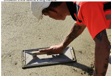
La talochage fin a été réalisé à la main.
