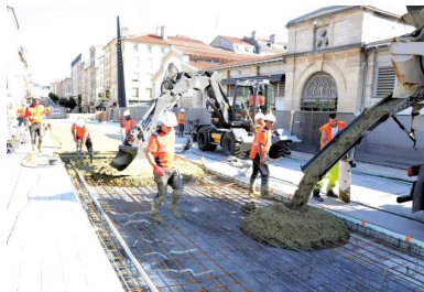
Le béton est délivré directement à la goulotte, puis réparti sur une épaisseur de 21 cm.
