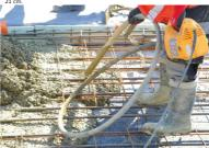
Une aiguille vibrante est utilisée pour chasser les bulles d'air et assurer une
