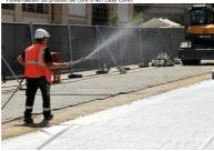
Un géotextile est déployé pour protéger la nouvelle chaussée. But : renforcer
