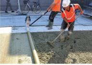
Le rouleau Striker a été utilisé pour une mise en œuvre rapide et pour obtenir u
