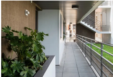
De longues coursives, équipées d'escaliers à chacune de leurs extrémités, desservent les étages.
