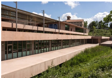
Les différentes unités fonctionnelles se répartissent en corps de bâti indépendants. Le bâti s'intègre à la pente naturelle du terrain pour se développer en une série de restanques.
