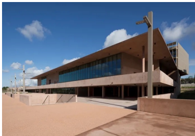
Le lycée est construit avec pour unique matériau le béton, au sol, aux murs et plafonds. Sa teinte reprend celle du site.
