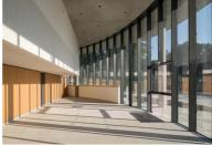
Le plafond du hall principal, façon faux plafond en béton gris autoplaçant
