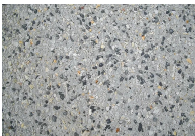
Le béton désactivé des cheminements intègre un mélange de granulats locaux Roche Blain (gris noir) et Barenton (gris blanc).
