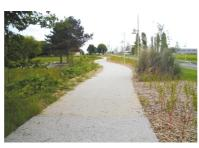
Produit dans l'unité Cemex de Giberville, le béton décoratif mis en œuvre sur les cheminements du nouveau quartier Kœnig est un béton C25/30 XF2 fibré (formule Nuantis Minéral de Cemex, ciment Calcia).
