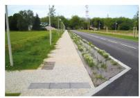
La voie cyclable étant partagée avec des piétons, des dalles podotactiles ont été installées pour guider les personnes à mobilité réduite. Les bordures de trottoirs en béton extrudé (profil CS1) permettent l'écoulement des eaux pluviales dans les noues végétalisées (et ici băchées).
