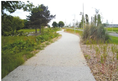
Produit dans l'unité Cemex de Giberville, le béton décoratif mis en œuvre sur les cheminements du nouveau quartier Kœnig est un béton C25/30 XF2 fibré (formule Nuantis Minéral de Cemex, ciment Calcia).
