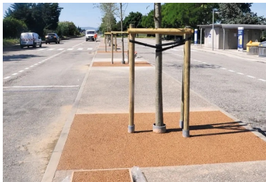
Peu après 12 heures, sur l'aire de repos de Bellevue, A7, sens Lyon-Marseille, au kilomètre 86. Les travaux sont achevés. Une planche d'échantillonnage a été réalisée. Elle servira à confirmer les performances du béton drainant.
