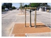
Peu après 12 heures, sur l'aire de repos de Bellevue, A7, sens Lyon-Marseille, au kilomètre 86. Les travaux sont achevés. Une planche d'échartillonnage a été réalisée. Elle servira à confirmer les performances du béton drainant.
