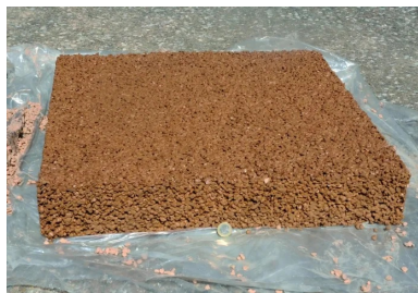
Peu après 12 heures, sur l'aire de repos de Bellevue, A7, sens Lyon-Marseille, au kilomètre 86. Les travaux sont achevés. Une planche d'échantillonnage a été réalisée. Elle servira à confirmer les performances du béton drainant.
