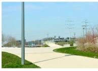
Pour réaliser le nouveau tronçon, quelque 300 m³ de béton Articimo® Stabilisé Terre de Sahara (confectionné sur la base d'un PSP 350 kg CEM li 42,5 N CE CP1 NF D11 S3 Terre de Sahara, 1.5 %) or été mis en œuvre et désactivés avec Artistab, spécialement conçu pour les bétons stabilisés.
