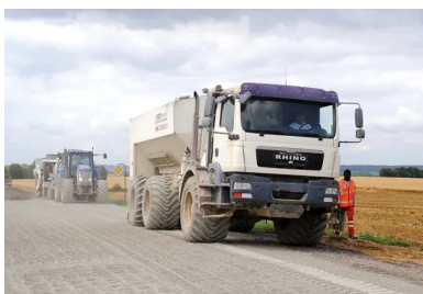
Épandage du liant hydraulique routier LVT5 54 de Vicat et vérification de la bonne répartition du liant au mètre carré (méthode dite « à la bêche »).
