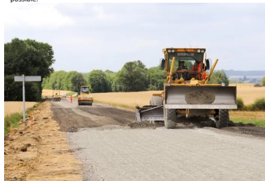
Passage de la niveleuse pour un bon uni et le meilleur profil géométrique possible.
