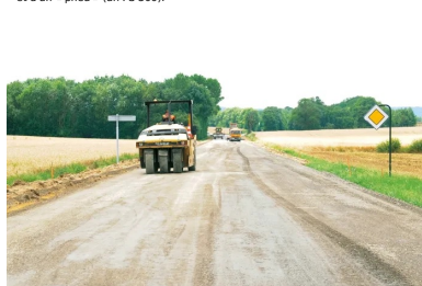
L'atelier de compactage composé d'un « vibrant » (un cylindre monorouleau V5) et d'un « pneu » (un PS 300).
