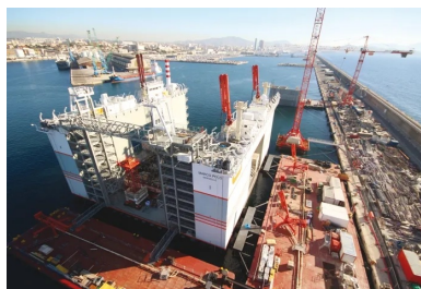
Les caissons sont fabriqués l'un après l'autre dans un caissonnier installé dans le bassin est du Grand Port de Marseille. Ce dock flottant unique en son genre s'enfonce dans l'eau au fur et à mesure que le caisson prend de la hauteur et s'alourdit.
