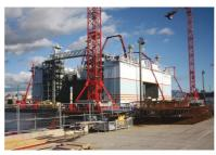
Le bétonnage continu des caissons est réalisé par l'intermédiaire de trois mâts de bétonnage, reliés sur le quai à trois pompes à béton, alimentées par des camions tounies béton
