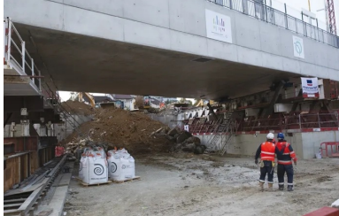
Pont-dalle à Arcueil - Cachan. Après le coulage et quelques jours avant le ripage.
