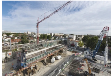
Réalisation du pont-dalle.
