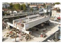
Avancée du chantier à Arcueil - Cachan avec mise en place du pont-dalle
