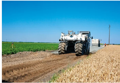
Le malaxeur Wirtgen 2400 intervenant sur une épaisseur de 45 cm de profondeur.
