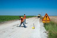
À droite, contrôle de la régularité de l'épandage et de la quantité des liants réalisé par la méthode dite « à la bâche ». À gauche, préparation d'un test de compacité. En médaillon, résultat à l'issue du malaxage : le liant clair a été
