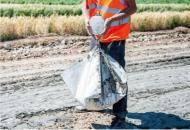
ontrôle de la régularité de l'épandage et de la quantité des liants réalisé par la méthode dite « à la hâche »
