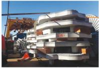
Dalles Rague en béton bicouche de Seaboost, sur le quai, avant leur mise à l'eau dans la calangue de Cortiou
