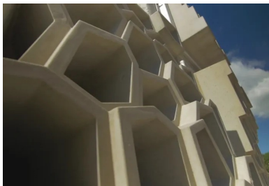
À la Réunion, le Panel® , « casier » alvéolé en CCV, conçu pour résister à une pression de plus de 10 tonnes par mètre carré.
