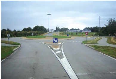
Carrefour giratoire de Saint-Pierre-la-Cour. Structure BC3g sur GB3, réalisée en 2005.
