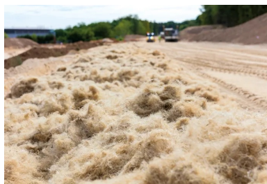
Épandage de la fibre de chanvre à l'aide d'un matériel spécifique innovant.
