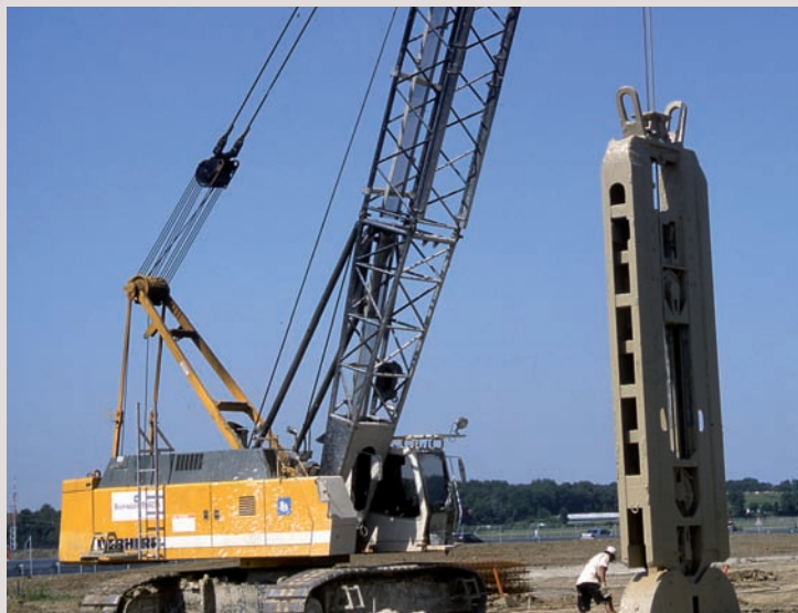
→ Creusement d'une paroi moulée avec une benne à câbles.
