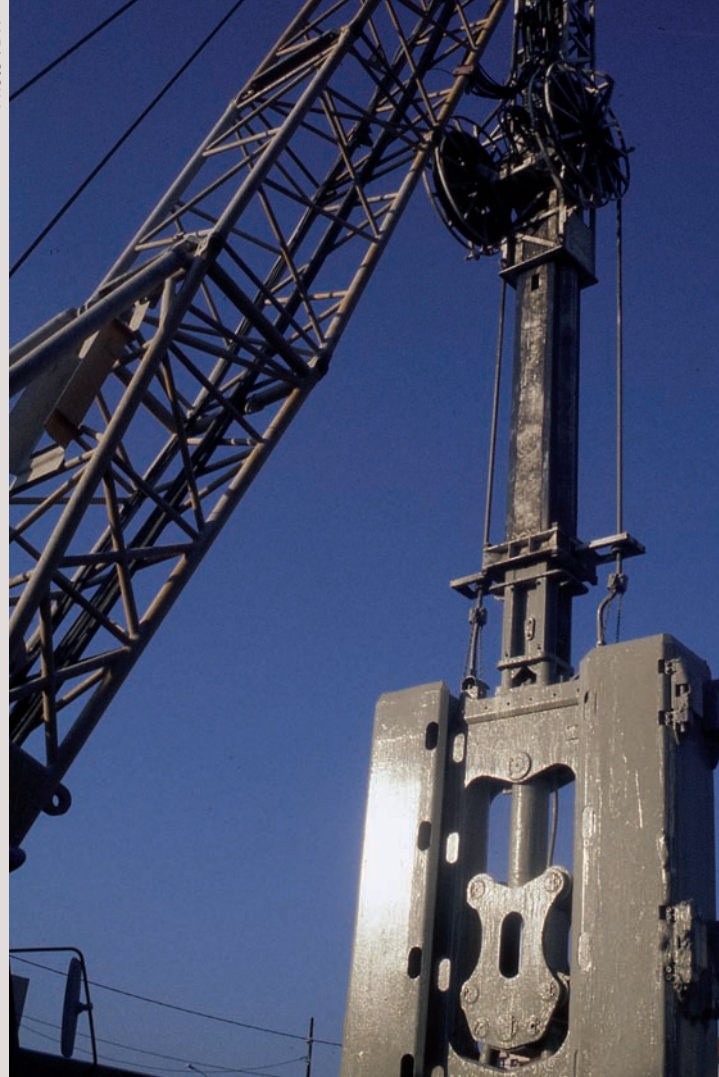
→ Creusement d'un écran étanche avec une benne à câbles.
