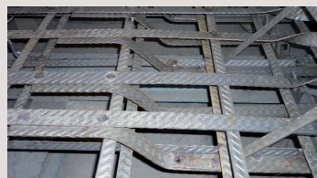
→ Ferrailage d'un dalot.
