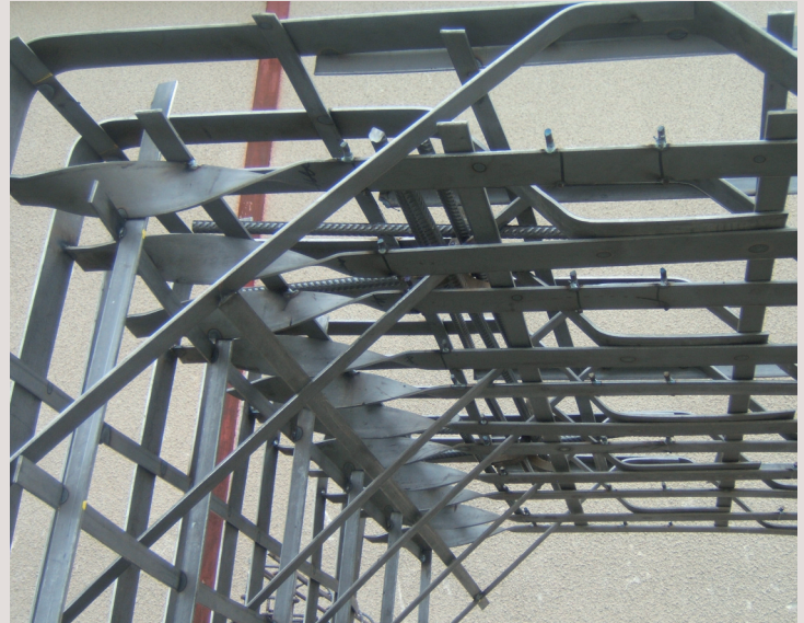
→ Ferrailage d'un dalot avec aciers plats lisses en période d'expérimentation.
