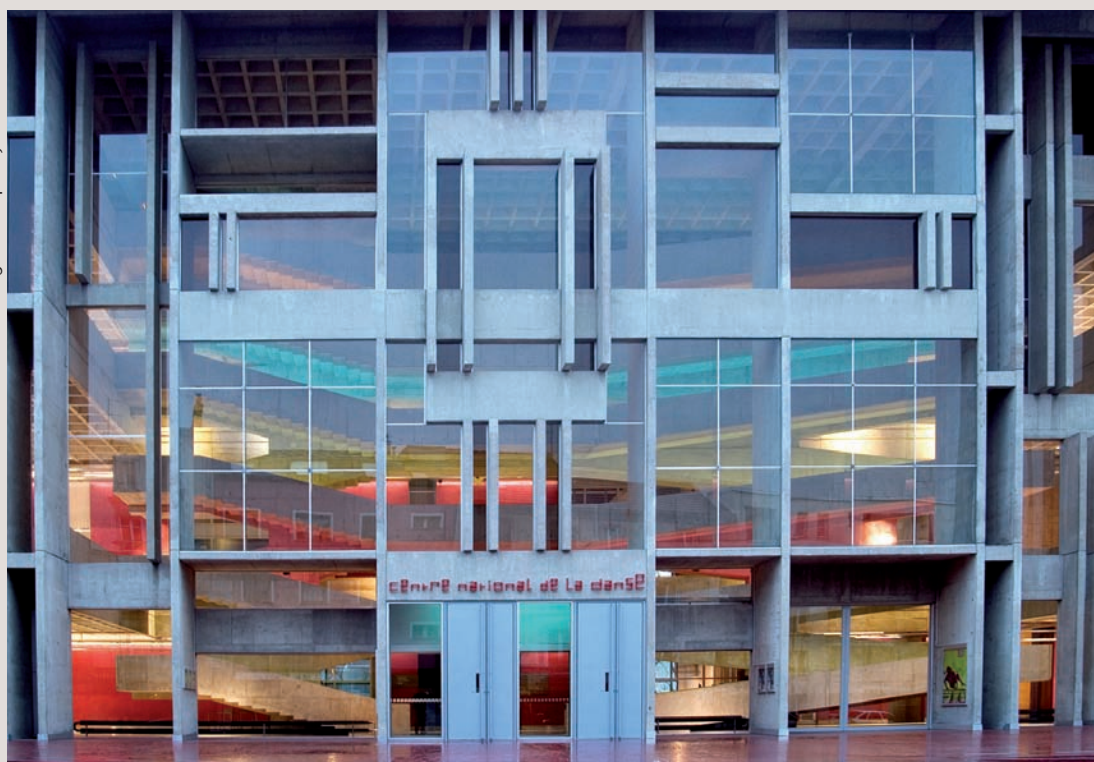
→ Centre national de la danse. Entrée et parvis. Signalétique Pierre Di Sciullo. Mise en lumière polychrome Hervé Audibert.
