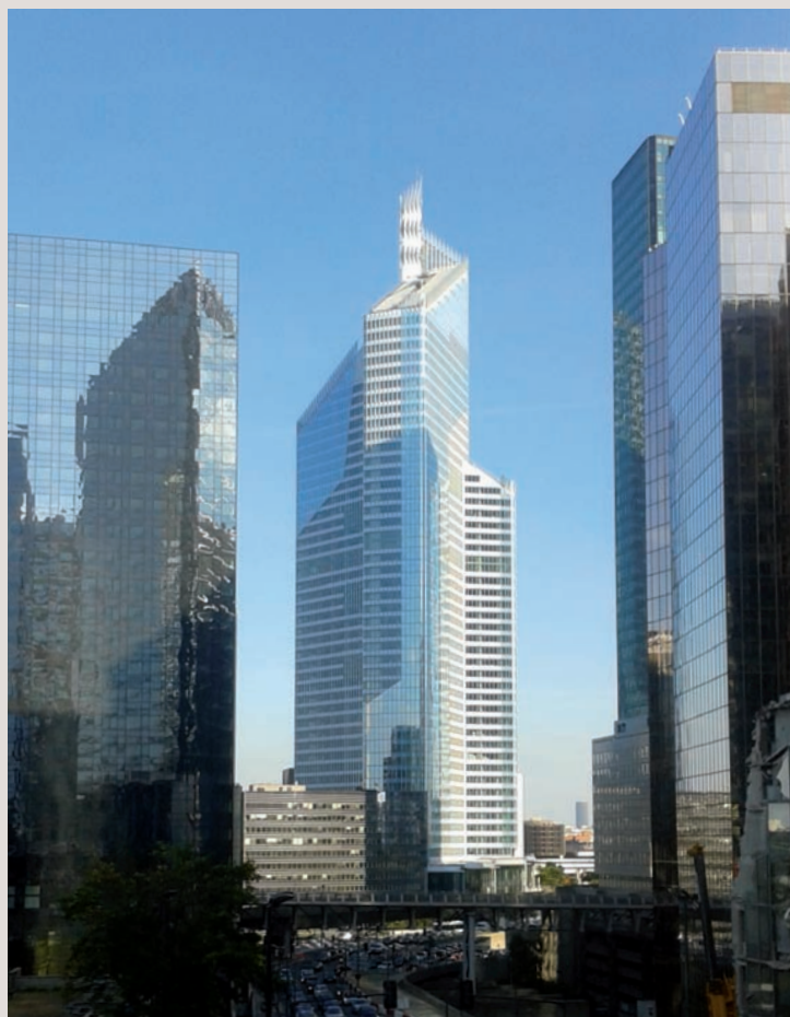
→ Culminant à 231 m, la tour First marque l'entrée de la Défense depuis Paris.
