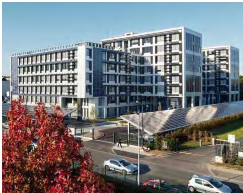
L'architecture bioclimatique du Green Office® de Meudon offre un confort thermique naturel sans climatisation, en profitant de l'inertie du bâtiment à ossature béton.
