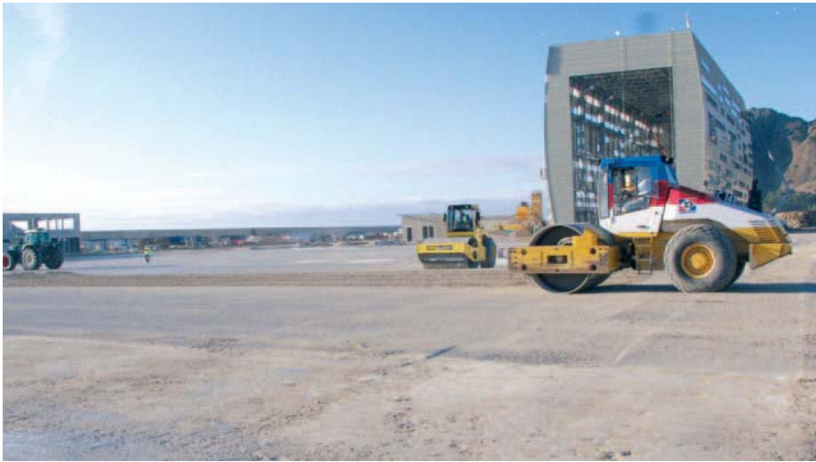
La vaste esplanade recevra des rails qui serviront ensuite à mouvoir les bateaux.
