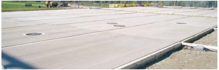
Gros plan de l'aménagement qui montre les différents rectangles de béton d'une surface de près de 19 m 2 chacun, les calepinages et les joints de construction.
