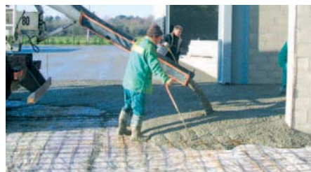
Coulage du béton prêt à l'emploi à l'aide d'une toupie et sur un treillis soudé.
