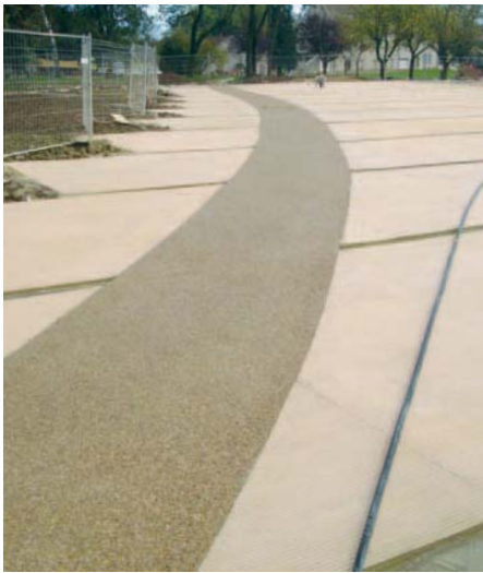
Une piste cyclable en béton prêt à l'emploi désactivé traverse l'esplanade.
