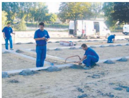
Préparation de la plateforme avant le coulage du béton prêt à l'emploi.
