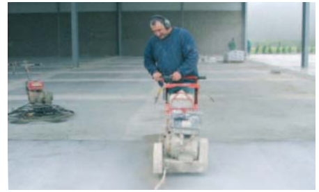
Sciage du béton durci.
