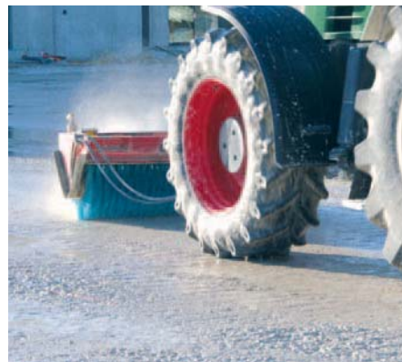
La bonne adhérence entre les couches est facilitée par un brossage énergétique.
