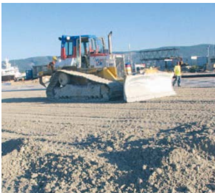
4 000 tonnes de BCR permettent de réaliser 1 600 m 2 en moyenne par jour.
