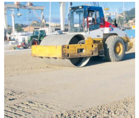
Chaque couche de BCR, nivelée par bulldozer, est ensuite roulée avec soin.
