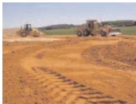
Egalisation au compacteur monobille.
