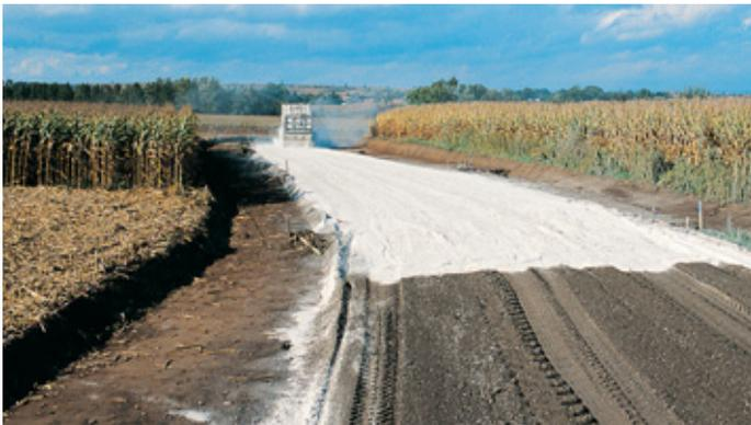
Épandage de liant pulvérulent sur la chaussée fragmentée à retraiter.
