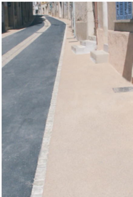
Camps-la-Source : du béton désactivé pour redonner du lustre à la Grand Rue.
