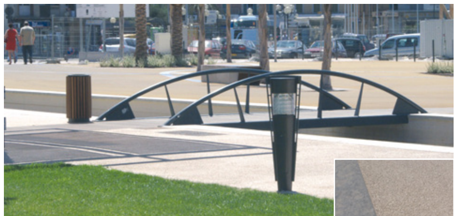
La Seyne-sur-Mer : la granulométrie très fine retenue pour le béton désactivé des allées permet de marcher pied nu au milieu du parc de la Navale.
