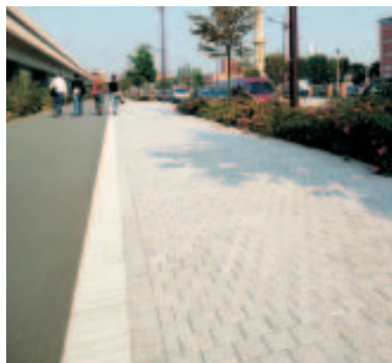
Avenue Oscar Lambret (Lille) : 21 000 m 2 de pavés béton et 6 400 mètres linéaires de bordures béton à parement naturel.
