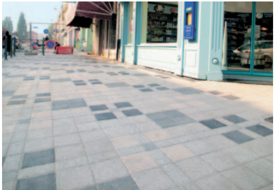
Faubourg des Postes (Lille) : 5 550 m 2 de dalles et pavés béton à parement granulat naturel, jouant sur les coloris blanc, gris clair, gris foncé et noir.
