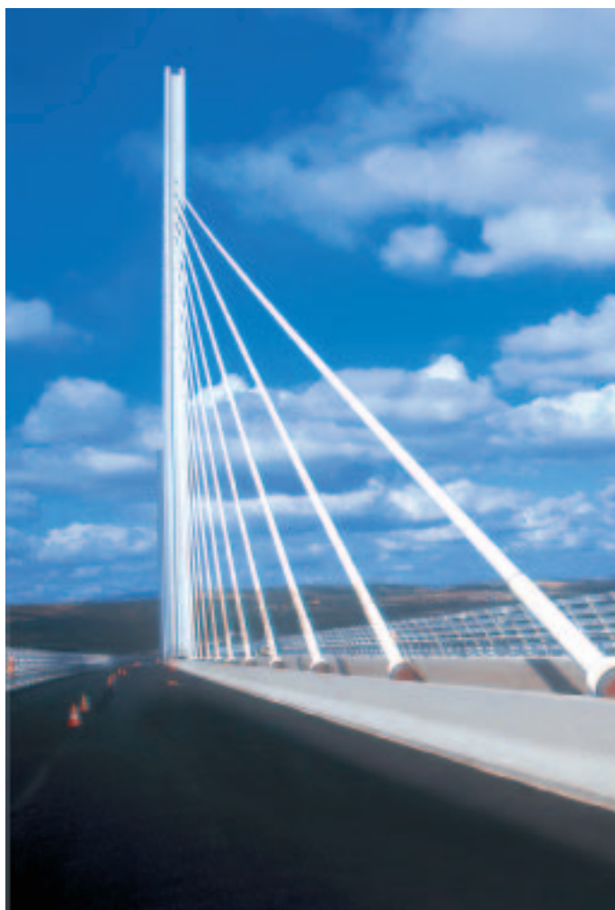
Le terre-plein central du viaduc de Millau (Aveyron) est équipé de glissières anti-franchissement en béton extrudé.
