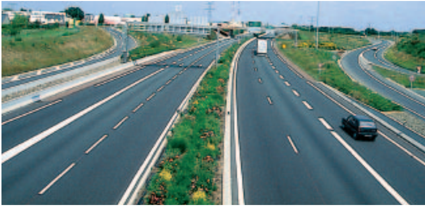
Double glissière végétalisée en site périurbain...
