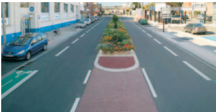
Sur les trois communes de Lille, Lomme et Lambersart : 11 200 m 2 de pavés en béton à parement de granulats naturels, de format 20 x 20 cm et d'épaisseur 8 cm, permettent aux chalands et aux piétons de se réapproprier tout l'espace public.
