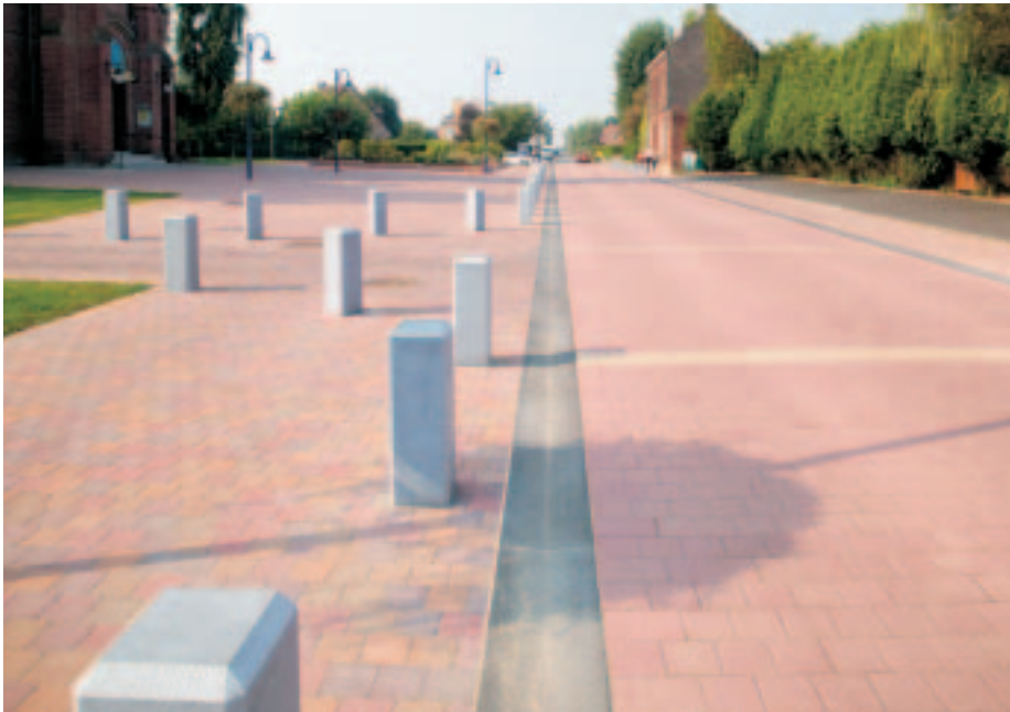
Place de l'église (Lompret) : 2 500 m 2 de pavés béton vieilli, couleur "feuille d'automne", et 200 m 2 de pavés à parement de granulats naturels.
