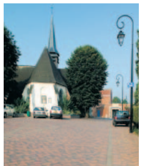
Place de l'église (Noyelles-lès-Seclin) : 2 100 m 2 de pavés granit rose de Péroles, de pav'dalles granit et de pavés béton vieilli.
