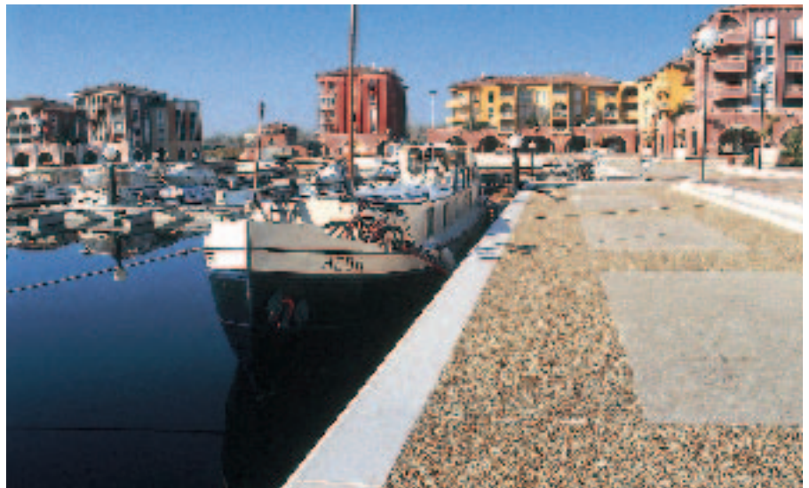
Lattes (Hérault) : le béton désactivé de Port-Ariane s’allie harmonieusement avec les couleurs des façades, apportant une touche moderne au nouveau port.
