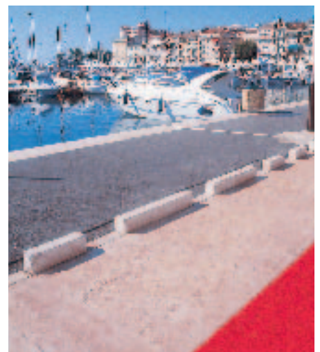
Cannes (Alpes-Maritimes) : le béton imprimé de l'Esplanade La Pantiéro rappelle couleurs et texture de la plage d'antan.
