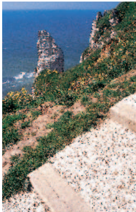
Etretat (Seine-Maritime) : des marches mariant béton désactivé et poutres de chêne.
