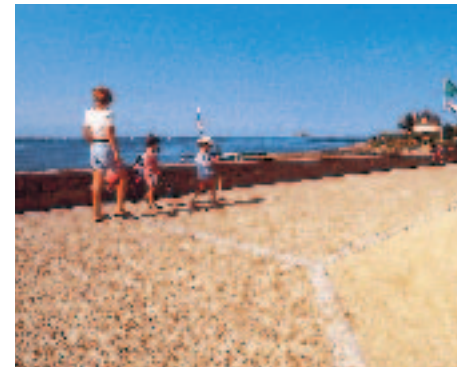
Arzon (Morbihan) : à Port-Navalo, un béton désactivé anti-dérapant et très confortable pour les promeneurs.
