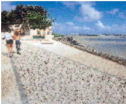
La Rochelle (Charente-Maritime) : du béton désactivé sur la promenade qui longe la plage de la Concurrence.
