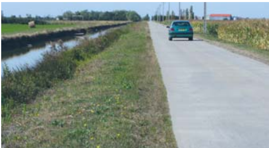
Marans (Charente-Maritime) : dans le marais poitevin, la chaussée béton de 17 cm d'épaisseur a bien supporté les extrêmes conditions de sécheresse de ces dernières années.
