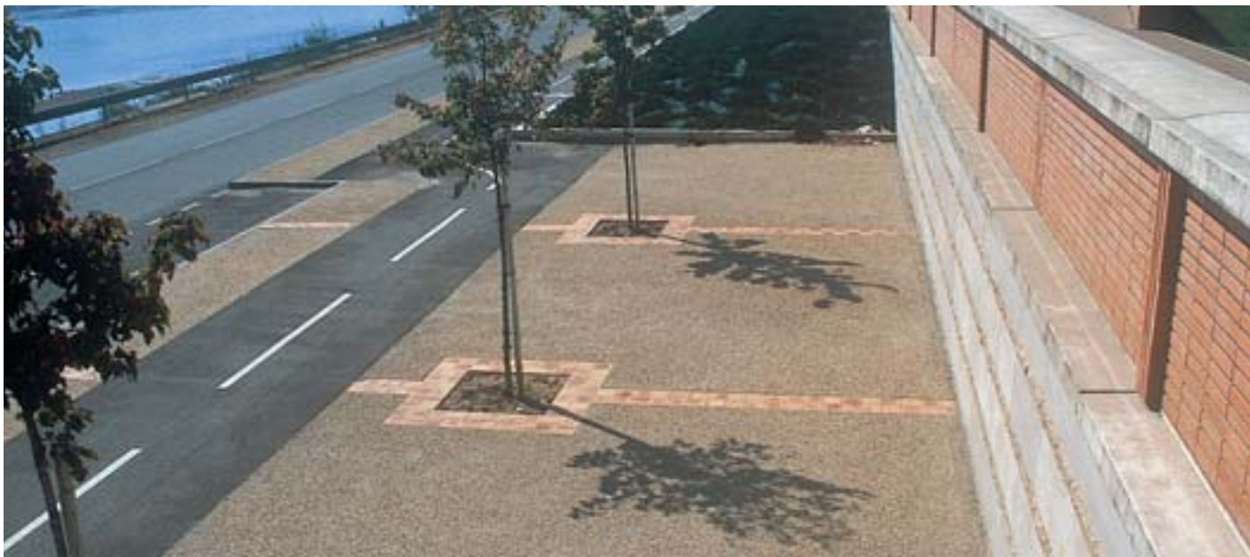
Le Passage (Lot-et-Garonne) : en contrebas de la digue qui longe le Lot, une zone en béton désactivé assure les échanges piétonniers entre la voie rapide et le bourg.
