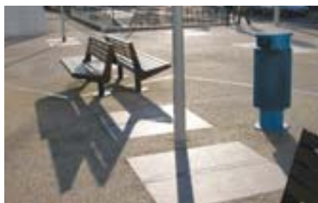
Au soleil couchant, béton désactivé, granit flammé et poli brillent de mille feux.
