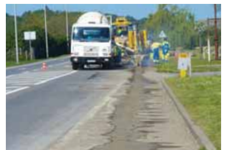
La circulation est rapidement ouverte avant les phases de rabotage et de finition.
