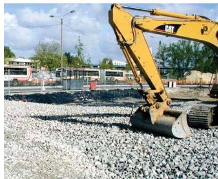
Mise en œuvre à la pelle mécanique.
