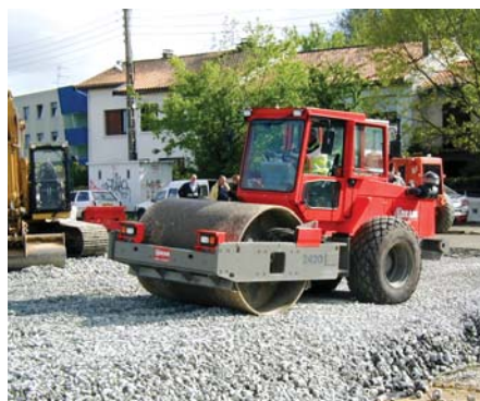
Opération de compactage.
