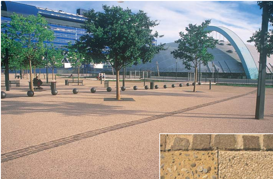
Hôtel du Département : deux types de granulats ont été utilisés, l'un pour l'esplanade, l'autre pour donner aux voies piétonnes un aspect plage.
