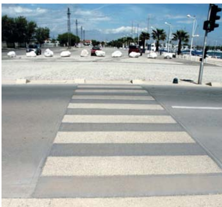
Port-Saint-Louis-du-Rhône : les bandes de béton désactivé remplacent la peinture blanche des passages piétons.
