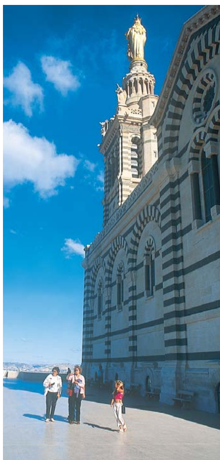
Notre-Dame-de-la-Garde : le parvis en béton poncé répond, à la fois, aux exigences techniques du site difficilement accessible et aux effets esthétiques recherchés par l'architecte Xavier David.
