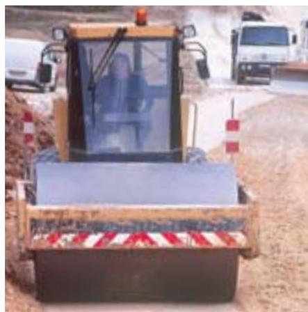
Le nombre de passes des compacteurs est déterminé in situ (avec des planches d'essais) afin d'obtenir la densité optimale.
