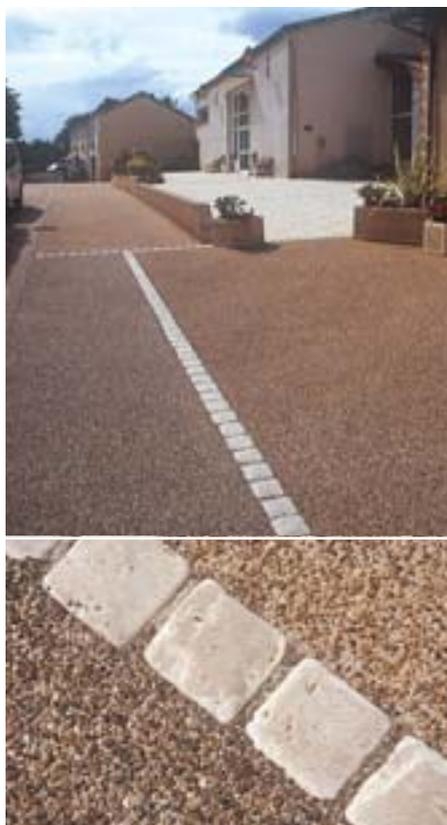
À Labéjan, deux bétons désactivés sont associés à des pavés béton marquant les limites de propriété, afin de différencier la chaussée des trottoirs.
