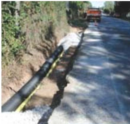
Phase d'assainissement avec mise en place d'un fossé drainant dans les faibles largeurs d'emprise.
