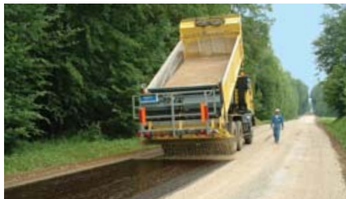
Protection de surface de la couche traitée.
