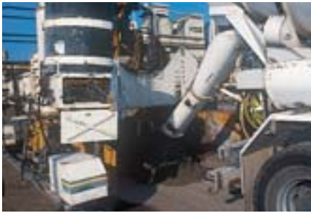
Des camions malaxeurs alimentent la machine à coffrage glissant.
