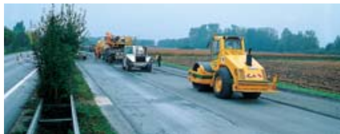
Le passage des compacteurs termine la mise en œuvre des matériaux recyclés en place.
