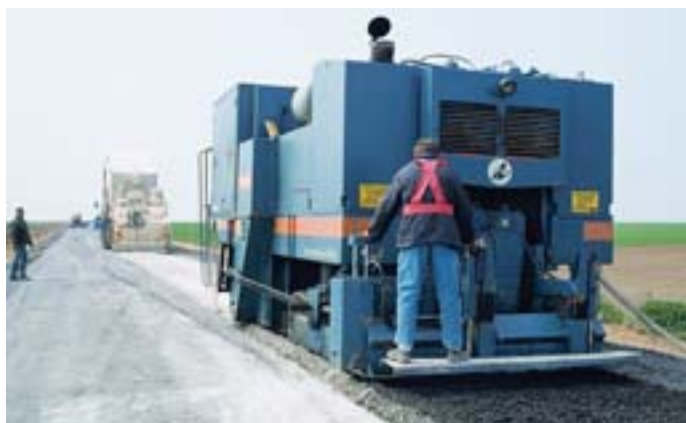
Atelier de reconditionnement de chaussée : ARC dosage et ARC 700 en action.
