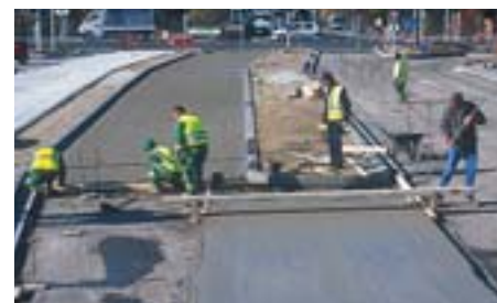
Un chantier associant des techniques de mise en œuvre manuelle et mécanisée du béton.
