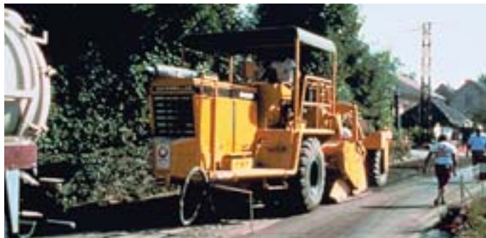
Malaxage à l'aide d'un pulvimixeur.
