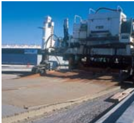
Le béton est lissé avec une bêche, traînée derrière la machine à coffrage glissant.
