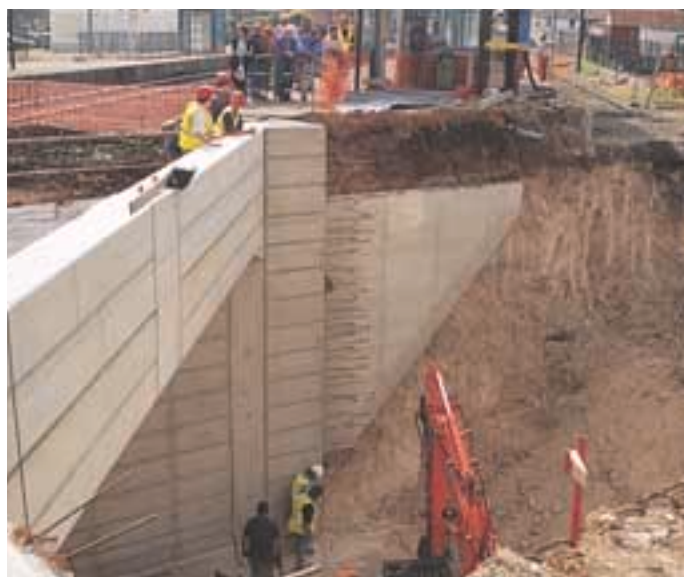
Ouvrage cadre mis en œuvre par "autoripage".
