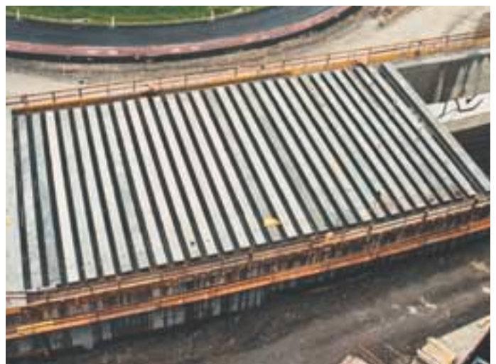
Couverture d'une tranchée couverte en poutres précontraintes.
