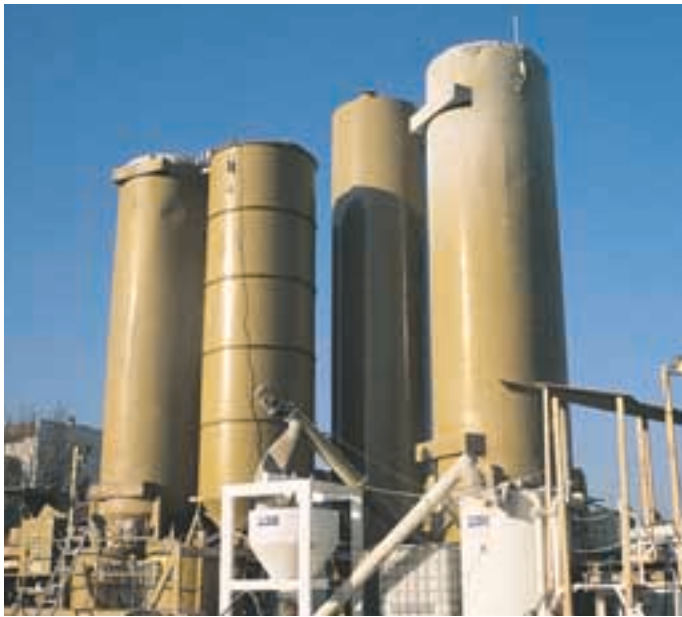
Centrale de fabrication du coulis bentonite-ciment.
