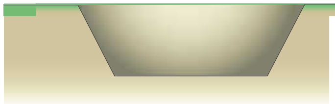
Terrassement de la tranchée en fouille talutée
