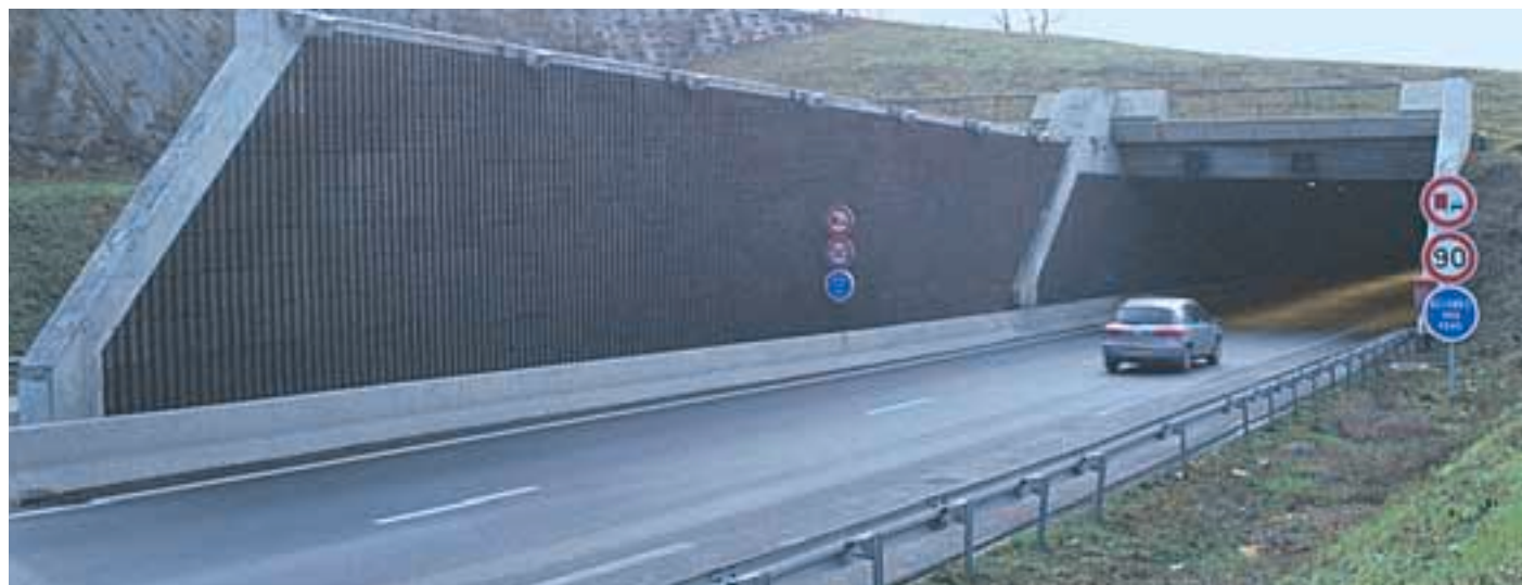
Tranchée couverte équipée de panneaux acoustiques.
