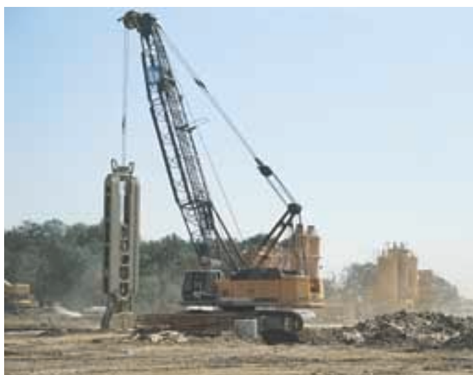
Réalisation d'une paroi moulée.
