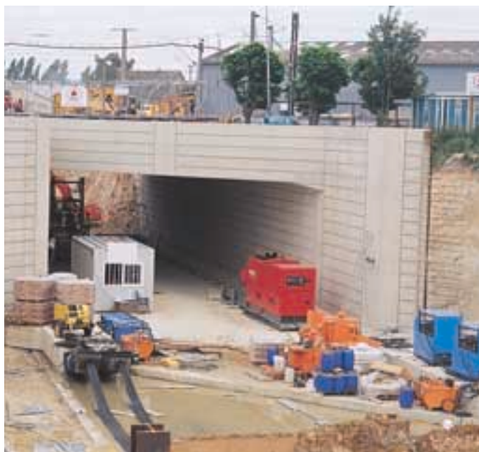
Ouvrage cadre mis en œuvre par "autoripage".
